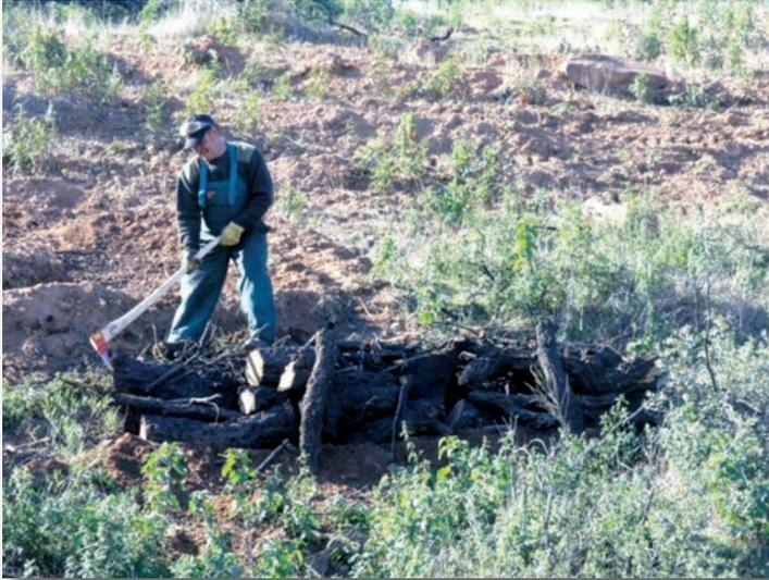
**Instalación de banquetas de troncos de restos de alcornoque quemado para la retención de sedimentos en áreas incendiadas.**
