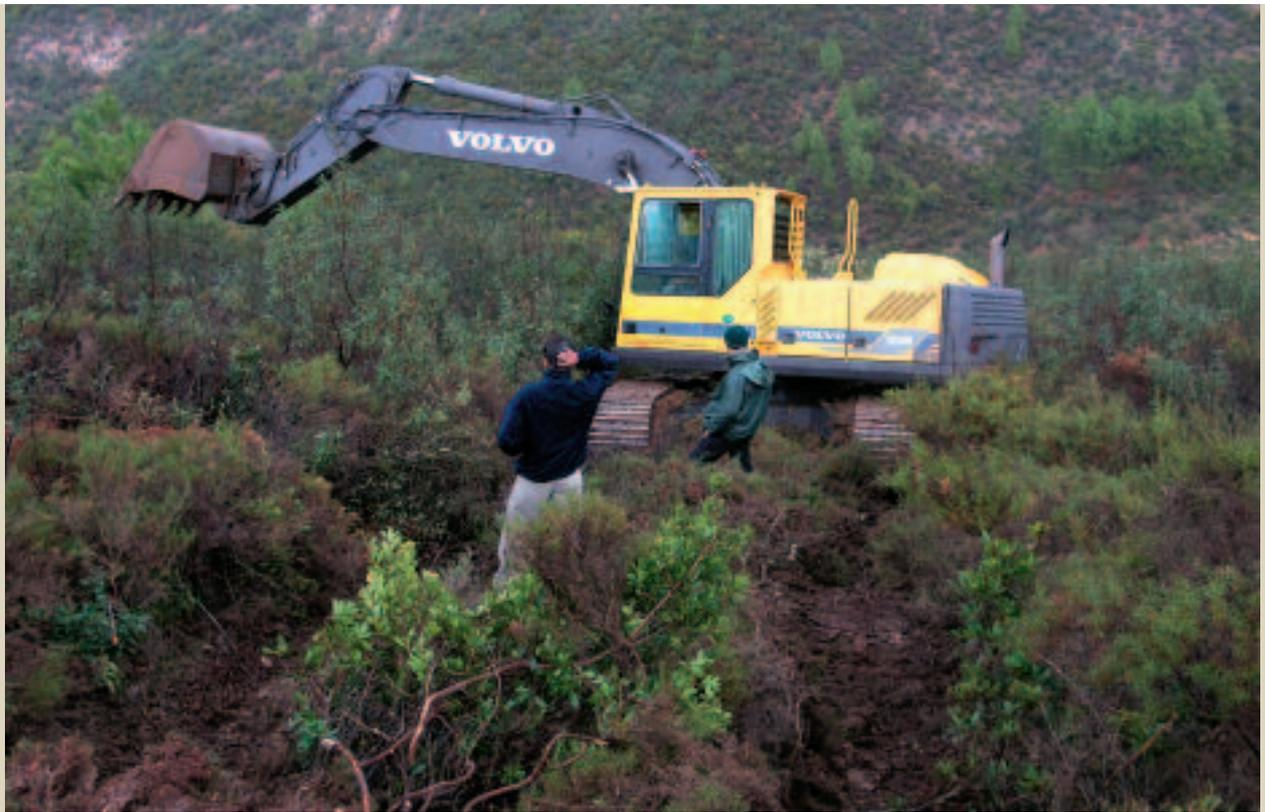
Retroexcavadora de gran potencia empleada para realizar banquetas en pendientes de hasta el 50%.
